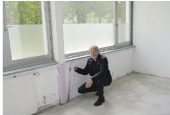
Klaus Stockmann zeigt den Sanierungsfortschritt im Vereinsheim an der Sandbergstraße | Foto: Kapels
